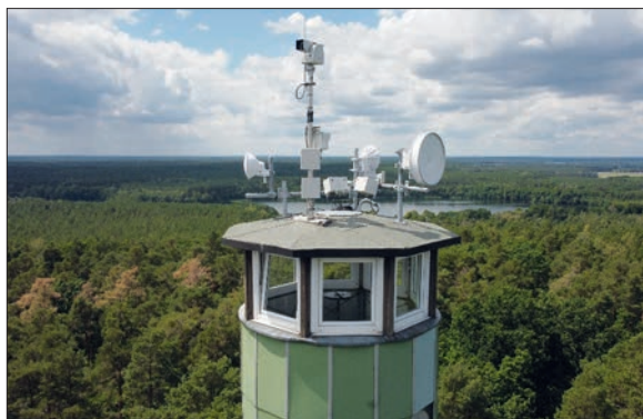
Die Sensoreinheit des IQ-FireWatch-Systems in Zesch am See, Brandenburg (Foto: IQ wireless GmbH)
